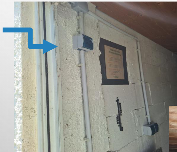
Unter Türschwelle durch und dann in der Garage Aufputz den Schalter für die Pumpe Und die Leitungen verlegt bis zur Verteilerdose und anschließen lassen.
