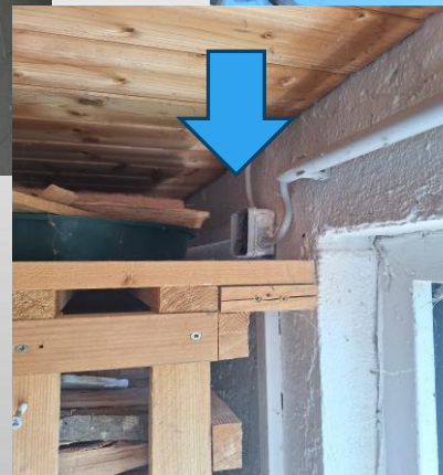
Unter Türschwelle durch und dann in der Garage Aufputz den Schalter für die Pumpe Und die Leitungen verlegt bis zur Verteilerdose und anschließen lassen.
