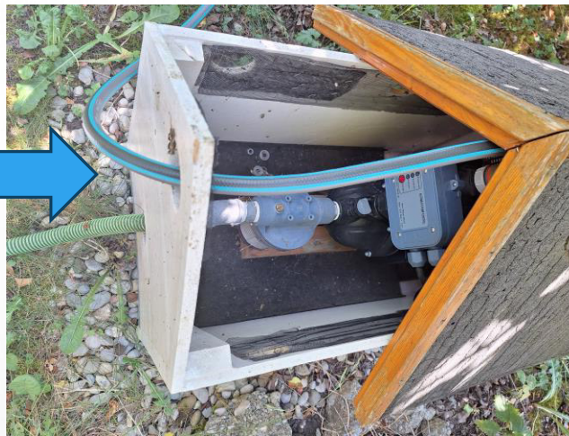
Selbstgebautes Pumpenhäuschen für Elektropumpe für Den Gartenbrunnen mit aufschiebbarem Dach
